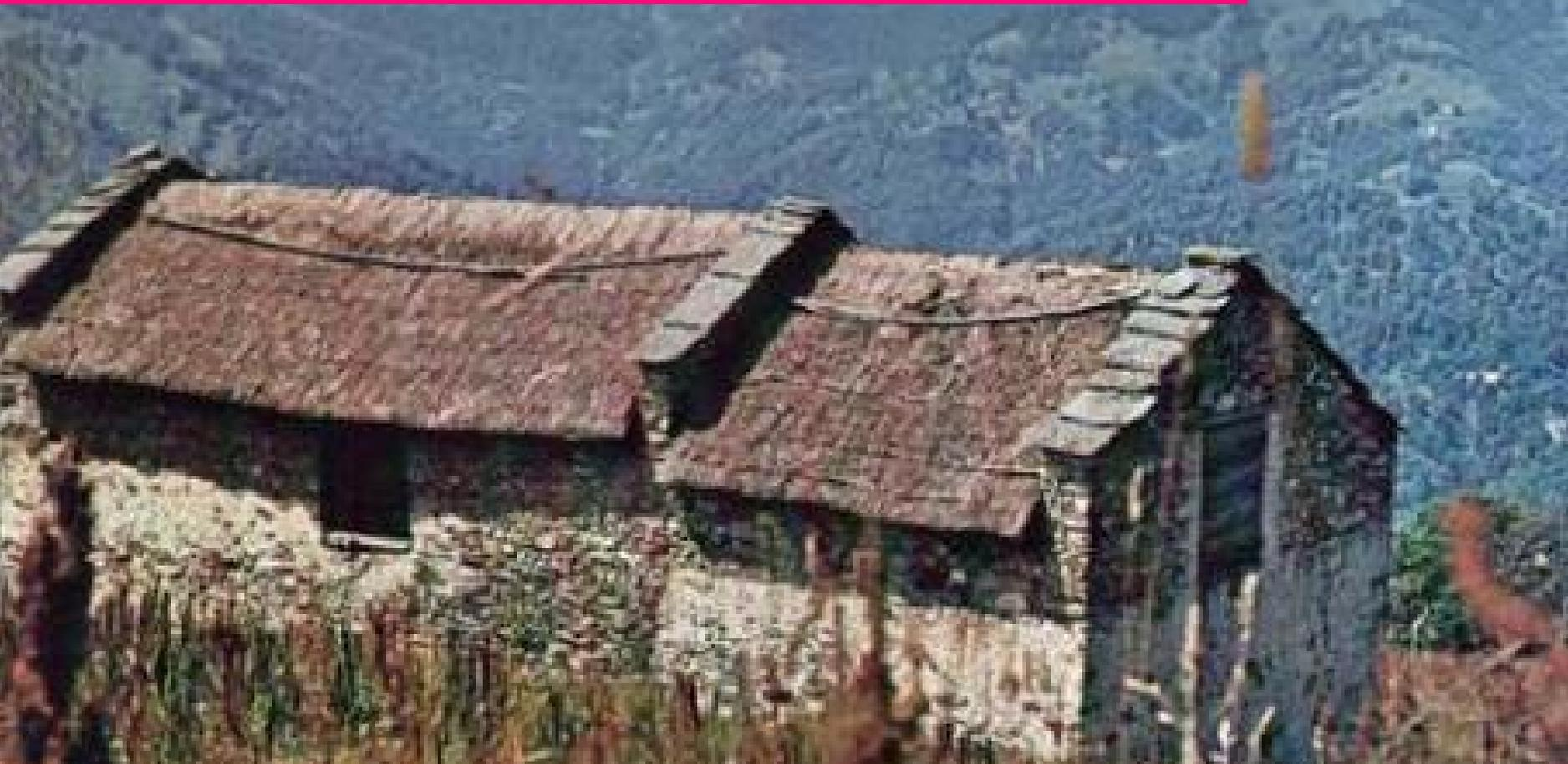
**TIPOLOGIA COSTRUTTIVA CON TECNICA DI COPERTURA DEL TETTO IN PAGLIA, ELEVANDO LA MURATURA DEI FRONTESPIZI OLTRE IL COLMO DEL TETTO, PROTETTA A SUA VOLTA CON LOSE IN PIETRA**
